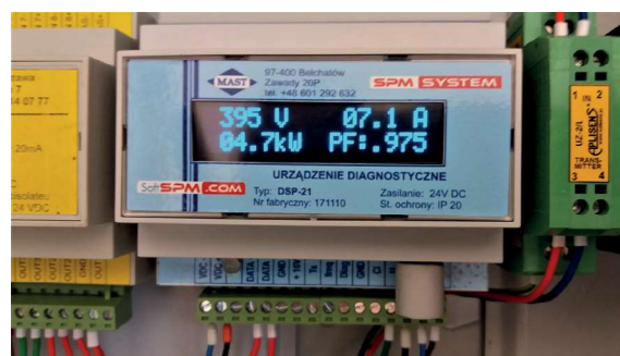
RYS. 4 Systemowe urządzenie diagnostyki głębinowego agregatu pompowego
